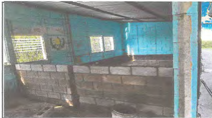
Foto 3: construccion de pared
