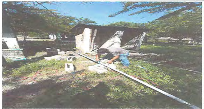
Foto 2: PROCESO DE INSTALACION DE BOMBA DE AGUA
