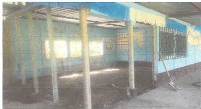
Foto 3: construccion de pared
