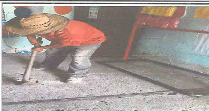
Foto 2: demolicion de torta de concreto en mal estado en aulas
