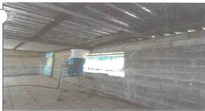
Foto 5: instalacion de energia electrica en aulas
