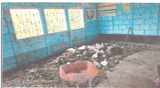
Foto 4: demolicion de tota en aulas
